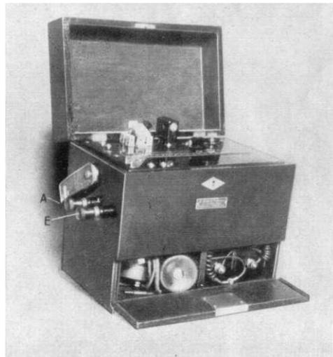
Abb. 23. Hörempfänger mit Prüfeinrichtung.
