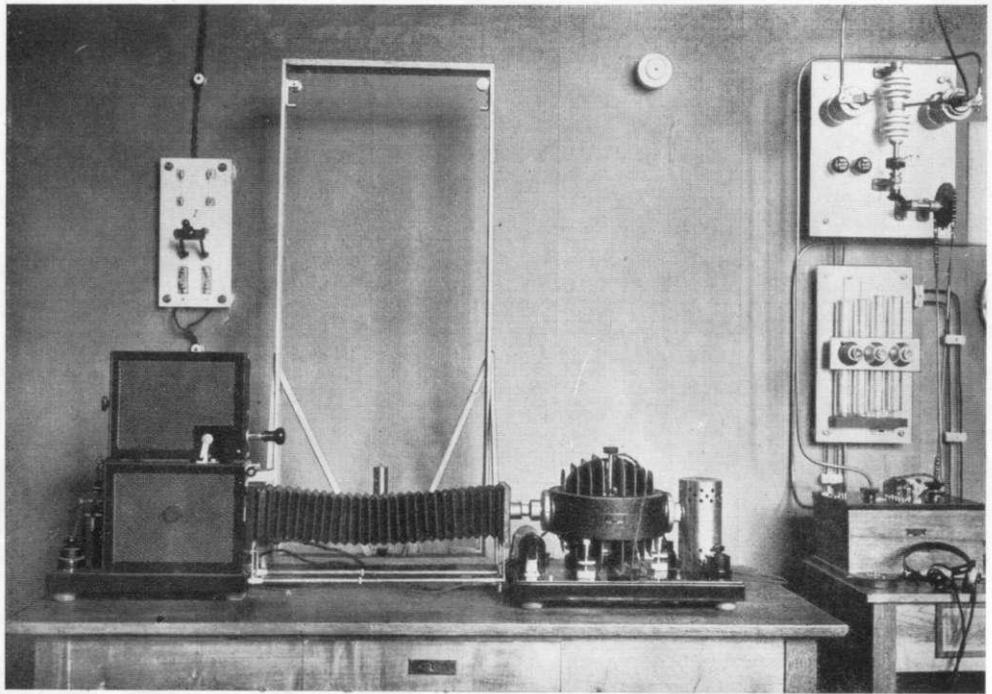
Abb. 43. Versuchsanordnung zur Selbstaufzeichnung des Zeitsignals. Saitengalvanometer mit photographischer Registrierung.
