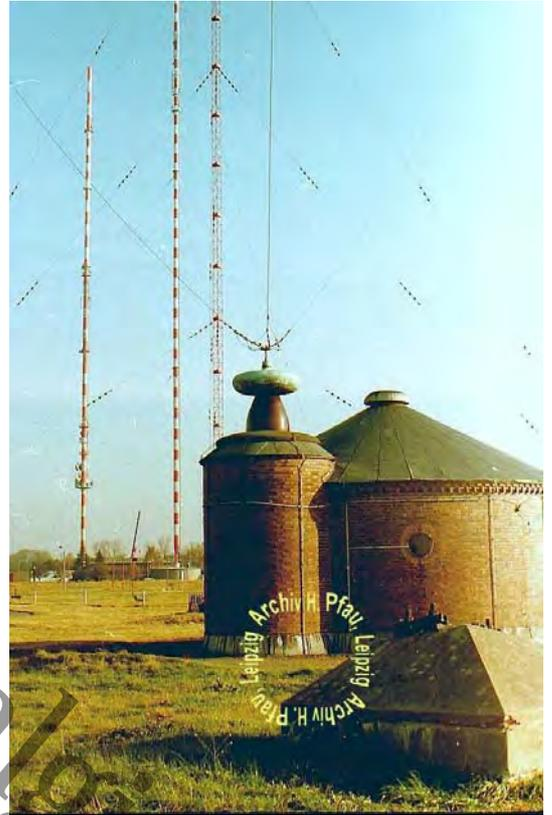
Bild 5: Antennen-Abstimmhaus unter dem alten Holzturm. Im Vordergrund ein Turmfußes.
