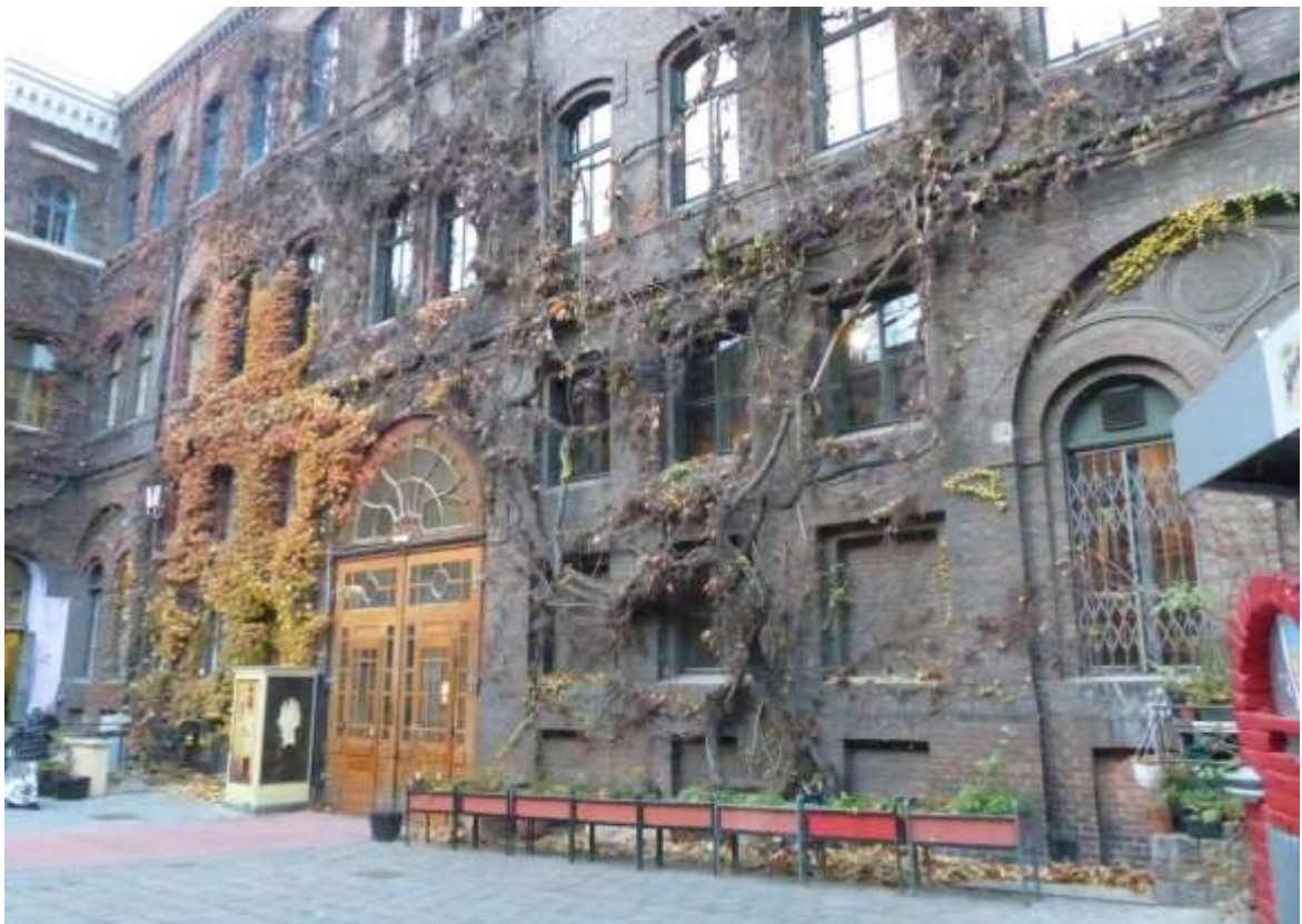
Blick in den Innenhof des Gebäudes „TGM“ in der Währingerstraße 59, der ehemaligen Sigl'schen Lokomotivfabrik
