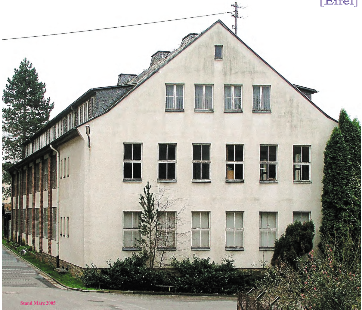
Sicht Stirnseite des Gebäudes
