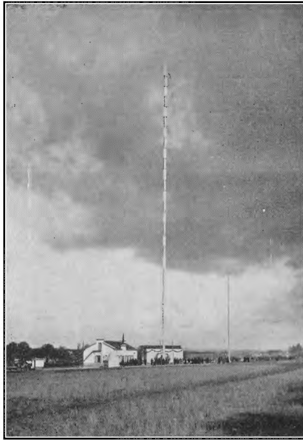
Edificio-estación y mástil central, de 90 metros de altura.
