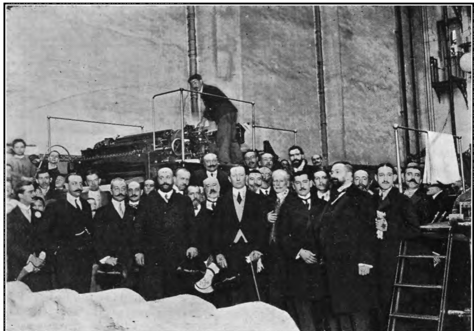
En la sala de máquinas de A B C.
