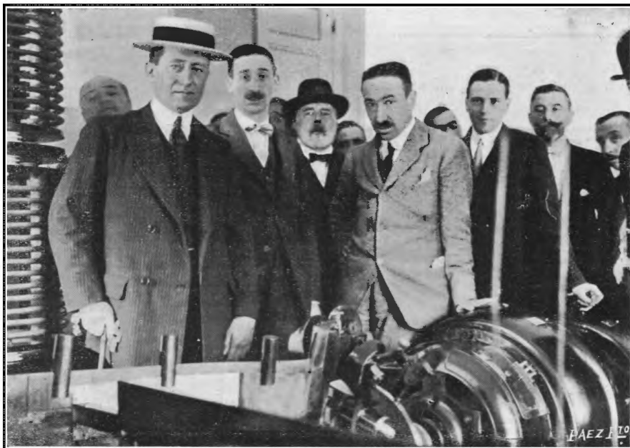
En la sala de aparatos de la estación central Aranjuez-Madrid.
