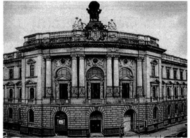
Das Gebäude Ecke Leipziger-/Mauerstraße.
