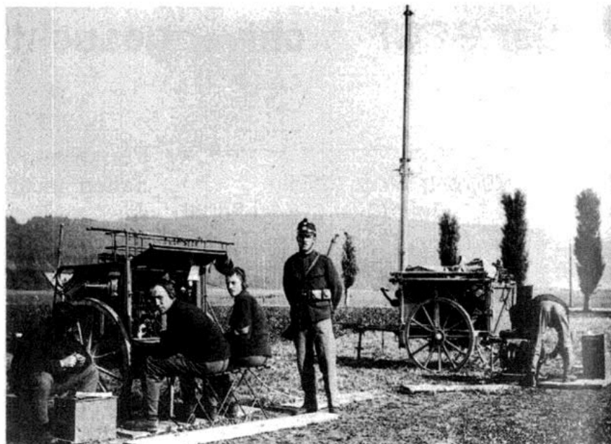
Bild 20: Fahrbare leichte Funkenstation 19 der Schweizerischen Funkentruppe (Telefunken Gfuk 18: 400-W-Löschfunktensender 0,4 TV 150-1600 m, Röhren-Audion-Empfänger E 213 a), aus [27].
