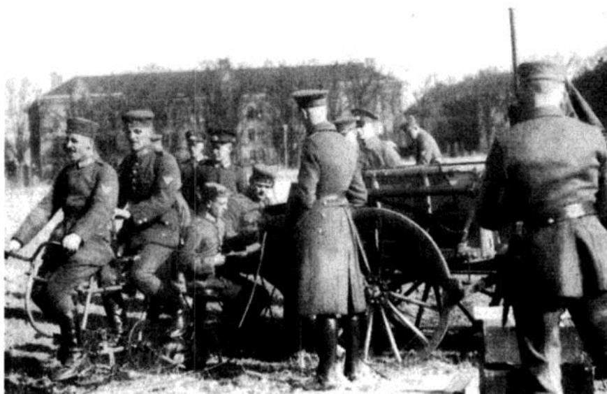
Bild 19: Kleinfunk 17 im Ersten Weltkrieg (etwa 1917). Die beiden tretenden Funker brachten 250 W an ihren Sender, aus [31].
