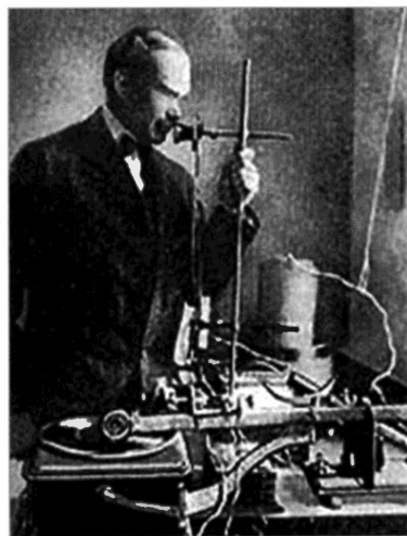
Bild 6: DE FOREST am Telefonesender (li. vorn: mechan. Plattenspieler), 1909 [7].
