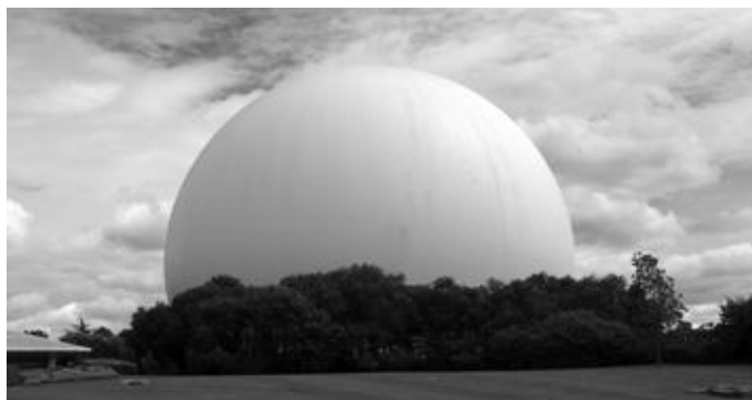
Das „Radome“ von Pleumeur-Bodou: Die Traglufthalle ist 50 m hoch und hat einen Durchmesser von 64 m (zum Vergleich: Das Radom Raisting hat eine Höhe von 35,50 m und einen Durchmesser von 48,80 m). Bild: INGO P TSCHE.
