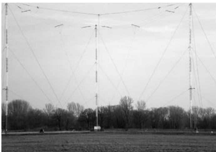
Bild 25. Die Dreieckflächenantenne für die Mittelwelle, Zustand 2010.
