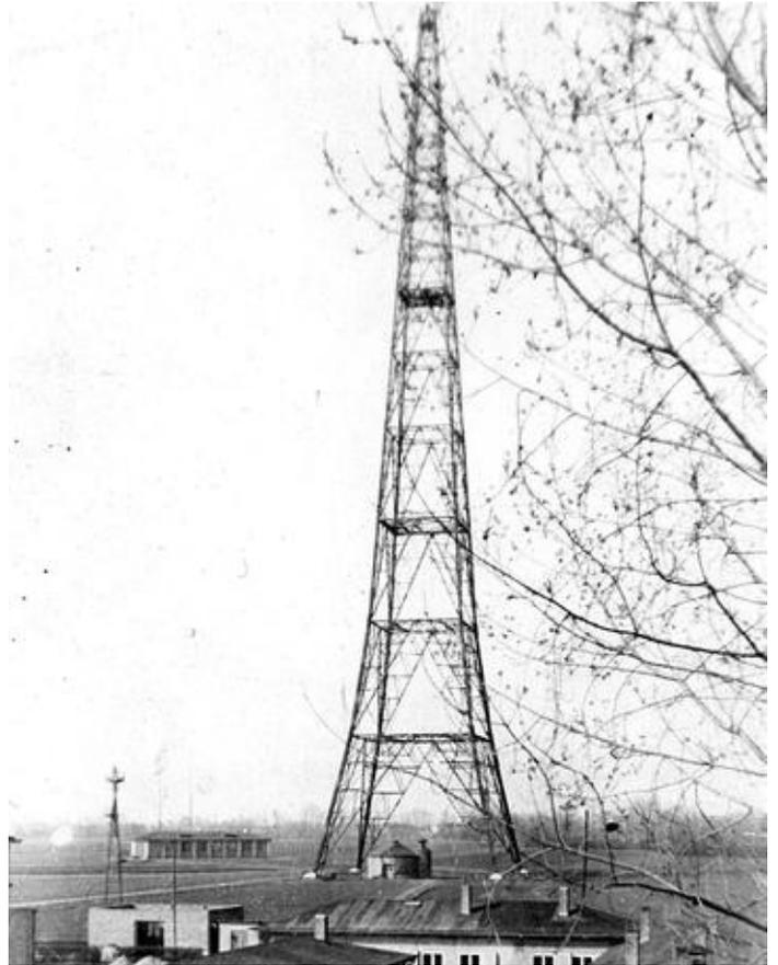
Bild 23. Der 1935 neu entstandene Sendeturm in Wiederau. Darunter das Antennen-Abstimmhäuschen, Zustand von 1952. \*
