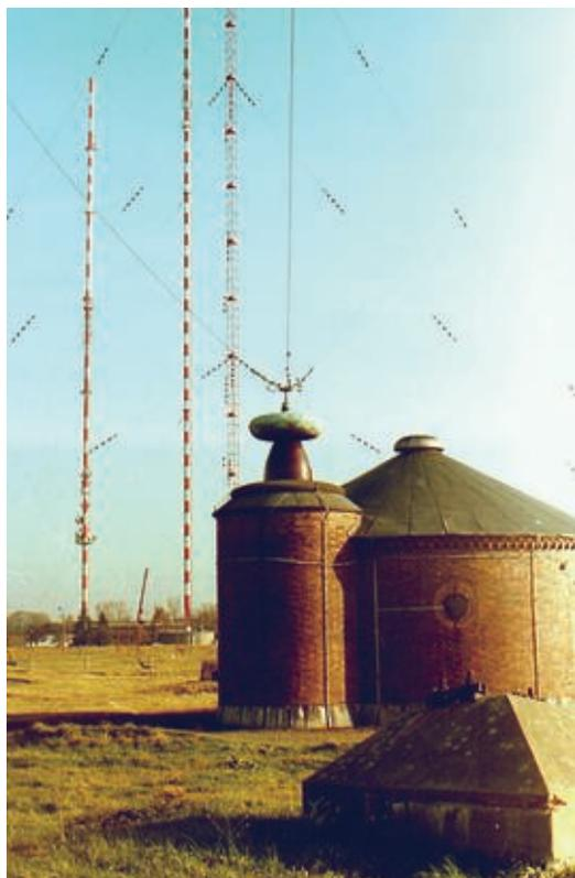
Antennen-Abstimnhaus von 1936, daneben Fundament eines Fußes des alten Holzturms von 1935, der 1953 gesprengt wurde. Im Hintergrund die beiden Rohrmasten (links 211 m von 1969 mit UKW-Antenne, rechts „J1“ 236 m von 1953/1958) sowie ein weiterer Stahlgittermast. (Bild: Hagen Pfau, 1991)
