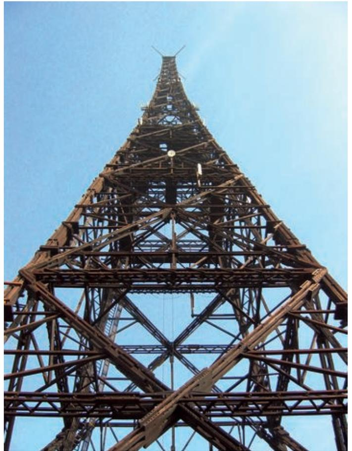
Bild 1. Der 1935 errichtete, 111 m hohe Holzmast des Senders Gleiwitz existiert heute noch.
