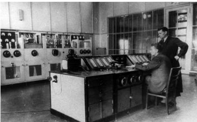
Bild 9: Der Senderraum des 1935 in Betrieb genommenen Lorenz-Senders. Auf diesem Bild, das etwa 1955 entstand, ist noch die Senderendstufe zu sehen, die heute nicht mehr vorhanden ist. Der Zustand dürfte dem von 1939 weitgehend entsprechen. Bild: FG-Archiv
