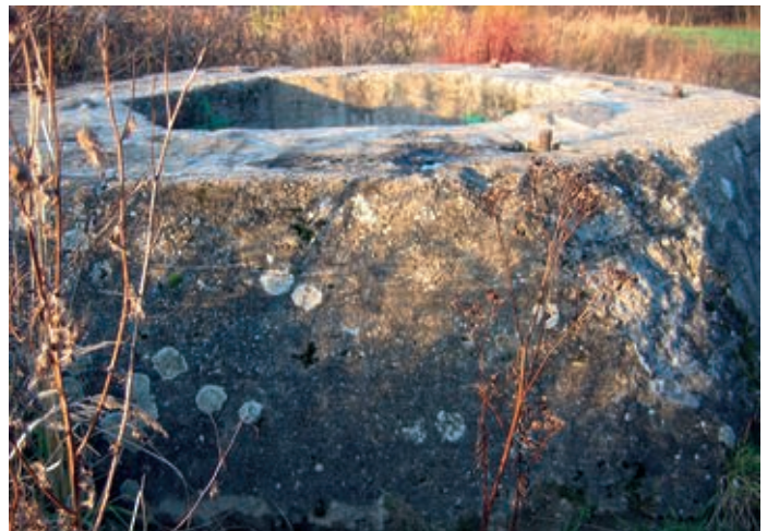
Der Betonsockel, auf dem die „Würzburg“-Antenne befestigt war. Man erkennt noch die Befestigungsbolzen.
