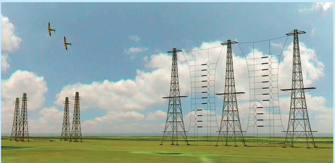
Das Chain Home-Radarsystem arbeitete mit Gruppenantennen, die in Form von Draht-Dipolen zwischen drei oder vier 110 m hohen Stahltürmen aufgespannt wurden. Links im Bild die Holztürme der Empfangsantennen. (Bild: Computernimation des MIT Lincoln Laboratory)
