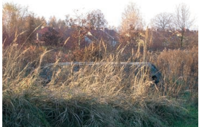
Etwas versteckt im Gestrüpp findet man das Fundament der Radar-Antenne. Im Hintergrund das Siedlungsgebiet von Pszczyna. (Bilder: MARIAN KOSTKA)
