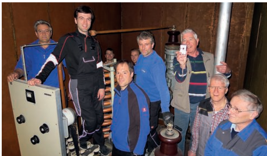
Der Demontage-Trupp im Hosenschalterraum.
