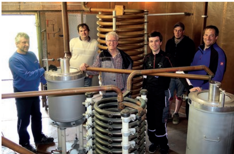
Im Antennen-Abstimmhaus: Auch hier alles riesig!
