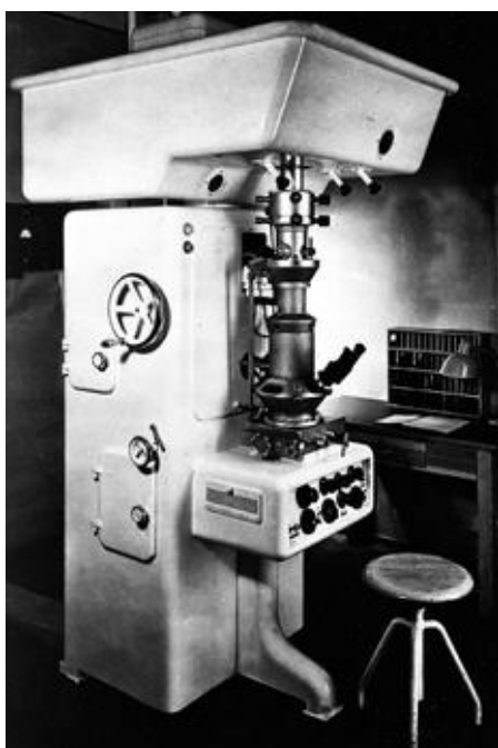
Bild 33. Nachbau des Elektronenmikroskop mit „Beuteteilen“ von Siemens.
