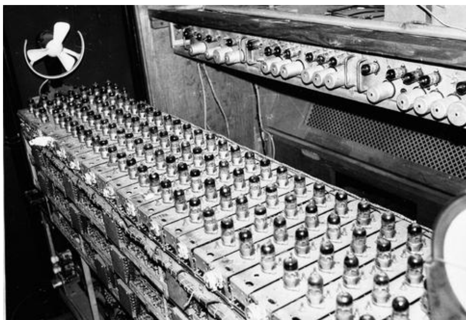
Bild 35. Die etwa 230 Röhren benötigen ungefähr 1,5 kW elektrische Leistung im Betrieb.
